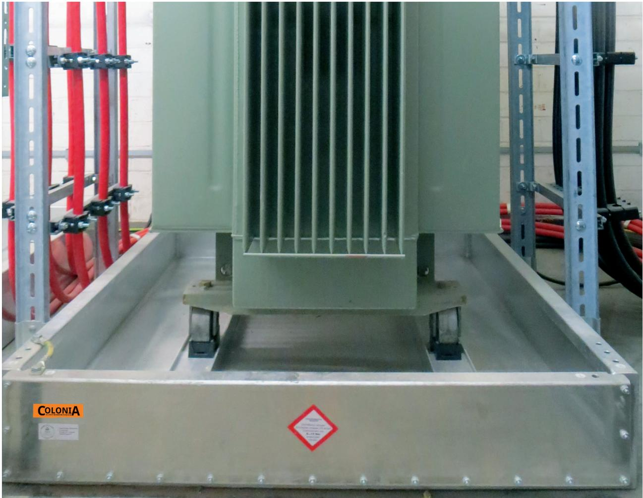
Zum Schutz gegen die Verunreinigung von Gewässern (§62 Wasserhaushaltsgesetz) sind Ölauffangvorrichtungen für Transformatoren unverzichtbar. COLONIA Elektromontagen, vormals Elsic Montage Hürth, bietet mit 20jähriger Erfahrung den Betreibern und Erstausrüstern von Transformatoren eine Auswahl an Ölauffangwannen, die höchsten Anforderungen an Montagefreundlichkeit und Korrosionsbeständigkeit genügen.
